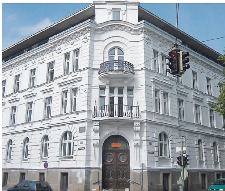
Das Haus der Senioren der Diakonie in der Welsener Dr. Schauer-Straße wird derzeit mit Unterstützung von Elektro Kagerer totalrenoviert.
